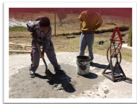
Ilustraciones 9. Construcción del cajón de estufa
